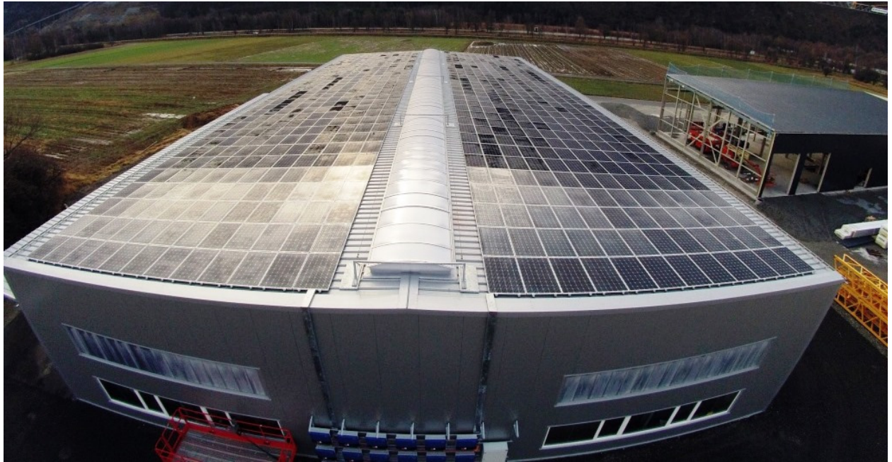
Photovoltaikanlage Späni, Raron
